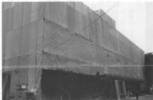
寺泊小学校は今春本山小、野積小を迎えての統合に伴い夏休み中に大改修工事が始まった。体育館は対震強化工事。安全安心を目指しての工事である。
