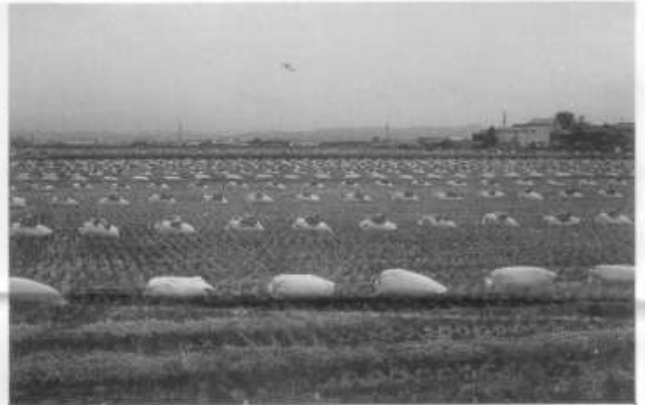
刈り終えた田圃の不思議な風景。 圃場設備と機械化で水気の多い田圃は暗渠工事が必要、 その準備段階。
