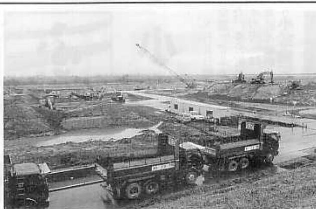
可動堰の下流に架かる橋の中間地点が寺泊(長岡市)と分水(燕市)の境。その河川敷で低水路の工事が進められている。北海道はじめ東北ナンバーの車が活躍中。(磯町 小松善憲さん提供)
