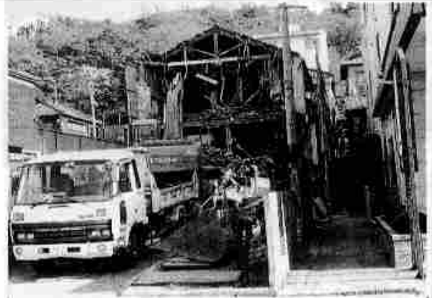
名門みや旅館の解体工事が始まった。平成9年の暮れで営業を終り、おしきや、みや旅館と言う歴史の幕は閉じられた。すぐ裏手の船形も已に解体、駐車場に変身。寺泊も一つの変わり目か。
