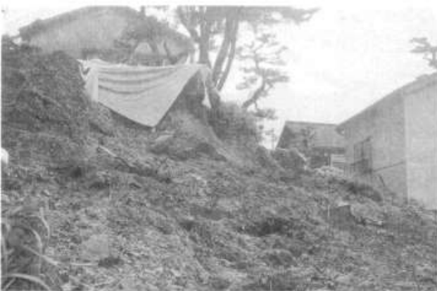
役場山手側の明治天皇行在所の土手が崩れ四軒の人家に一時避難勧告が出された。
