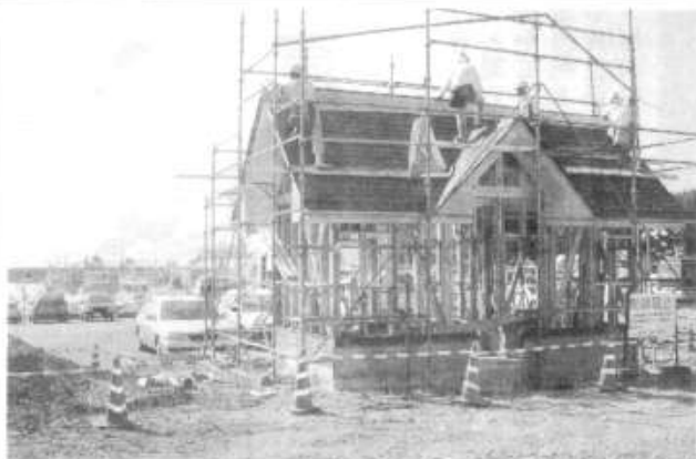
大町バス停は寺泊の産業の一つに成長した遊漁船釣船の発着地と隣接。公衆トイレが急ピッチで建設中。
