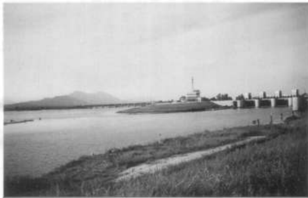
大河信濃川の分岐点。 左手が分水可動堰。右手は本流の洗堰。 萬にまさる業や心の花かざり (句佛)
